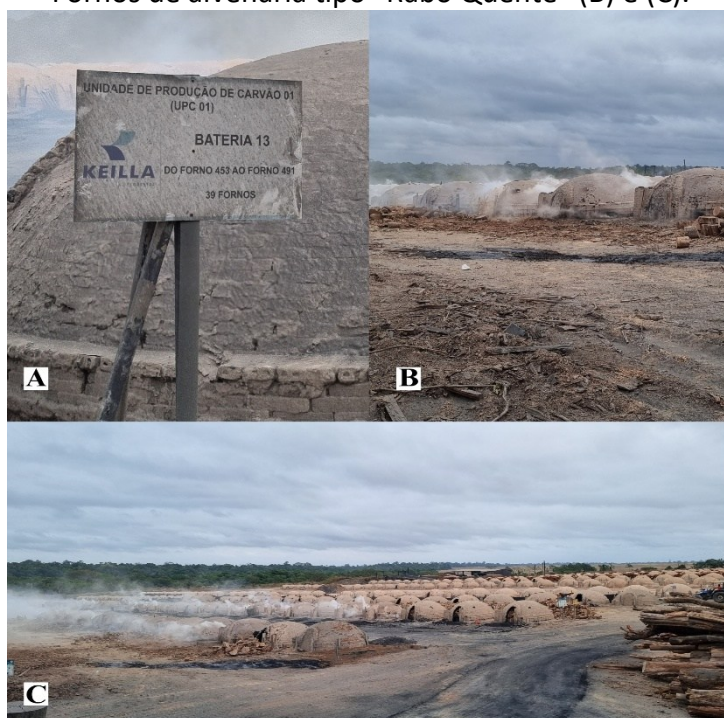
Figura 1 - Carvoaria da Fazenda Rio Capim, CKBV/ KEILLA S/A: Unidade de produção (A) e Fornos de alvenaria tipo “Rabo Quente” (B) e (C).
