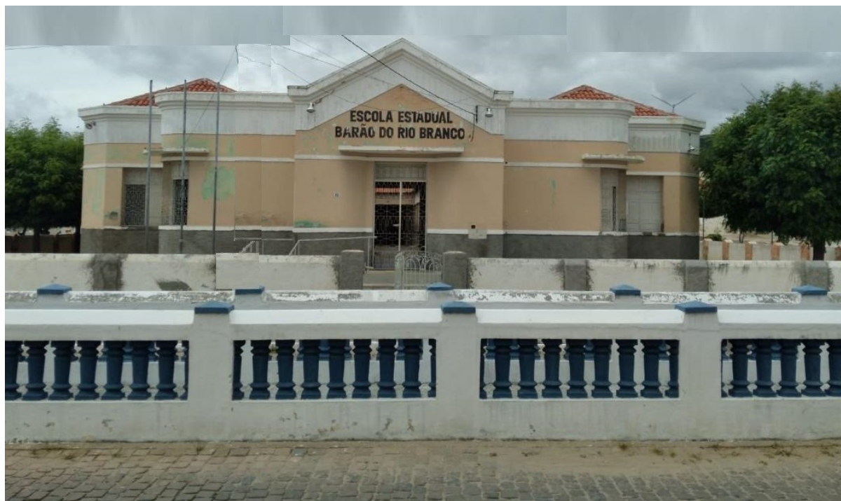
Figura 1 – Fachada da Escola Estadual Barão do Rio Branco, município de Parelhas/RN, 2024.
