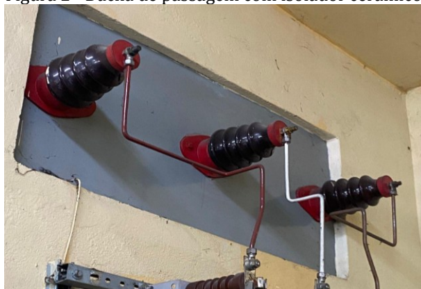
Figura 2 - Bucha de passagem com isolador cerâmico.
