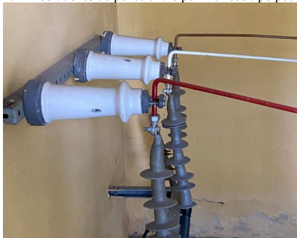
Figura 1 - Isoladores de porcelana e poliméricos tipo pedestal.
