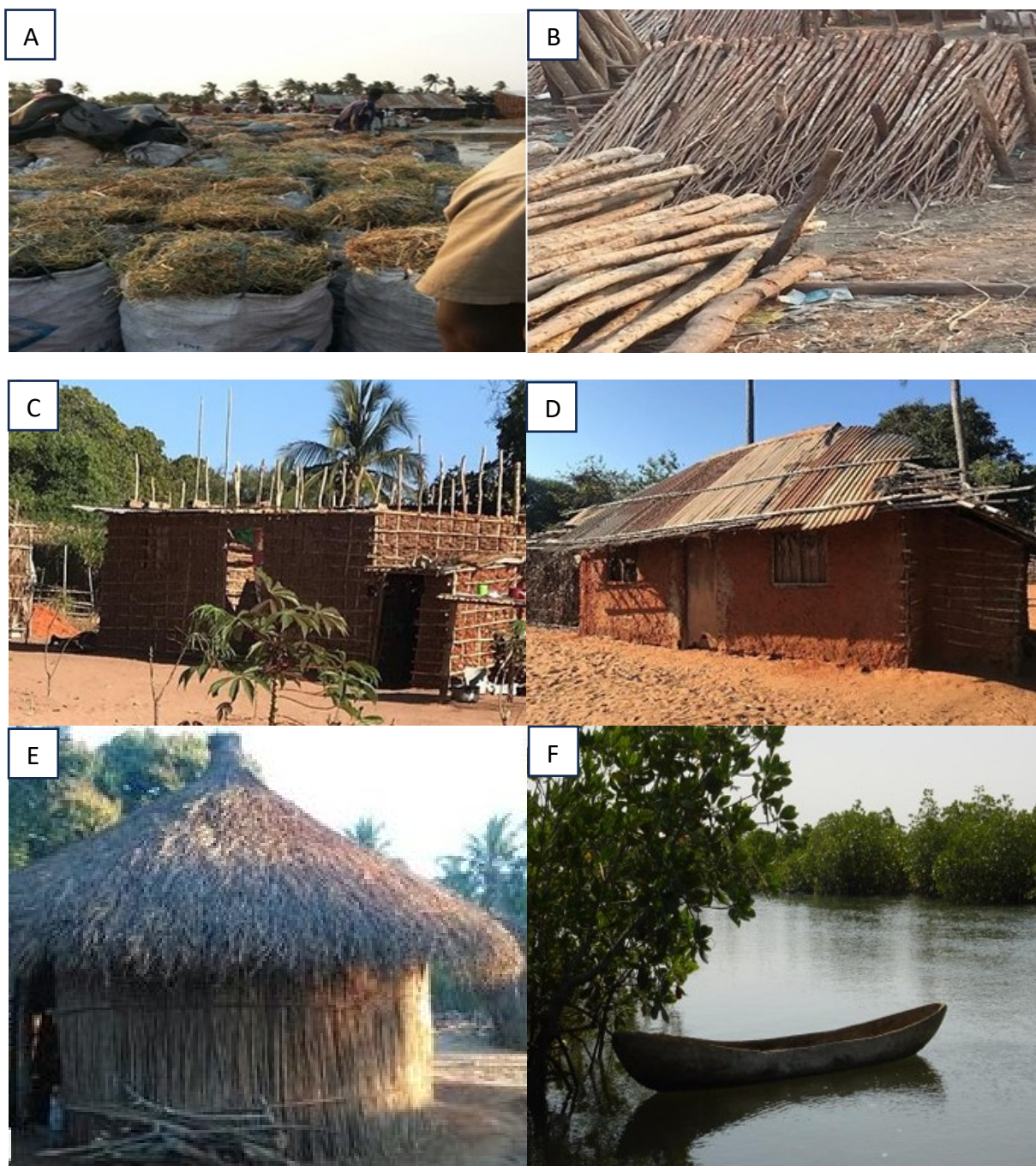
Figura 1 – Alguns exemplos de uso da madeira de mangue em Moçambique: (A) Estaleiro de carvão, (B) madeira e estaca, (C) habitação a pau a pique em construção, (D) habitação a pau a pique coberta com chapas de zinco, (E) habitação de palhota circular e (F) canoa (almadia), barco de pesca tradicional comumente usados pelos pescadores.
