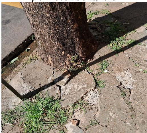
Figura 11. Colo pavimentado e canteiro próximo ao meio fio, 2025.
