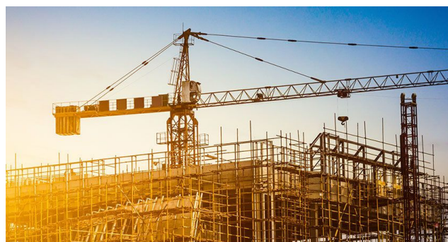
Figura 1: Obra de edifício vertical. Fonte: Souza (2024)
