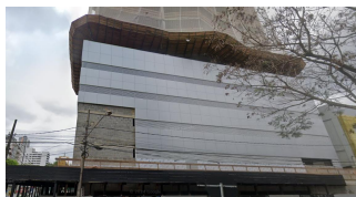
Figura 1: Edifício referência para o estudo. Fonte: Google Maps (2024).
