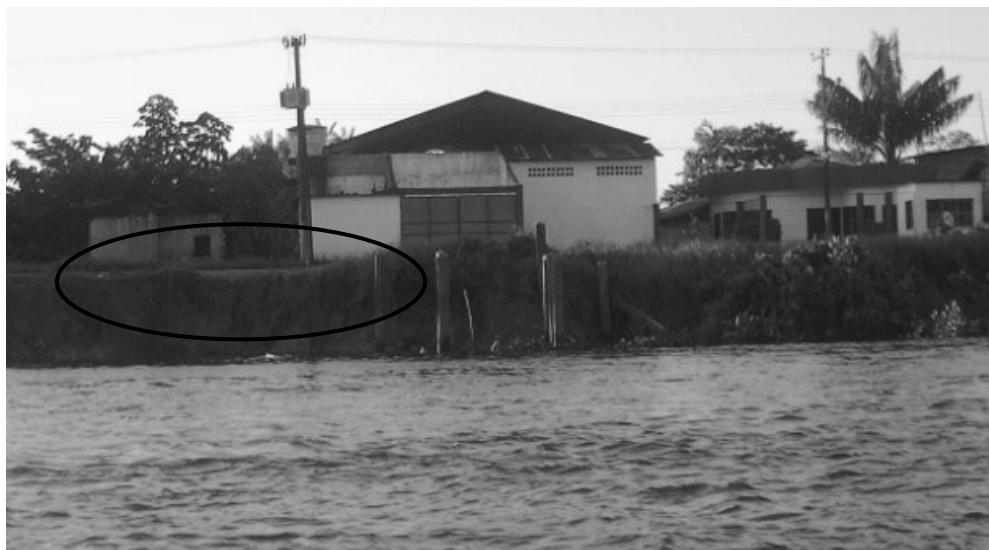
Figura 7. Erosão fluvial das encostas.
