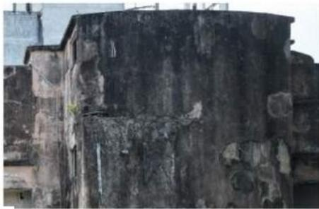
9a) Detalhe retirado da fachada norte, mostra Sujidade e Crosta Negra (D2) em grande parte da fachada.
