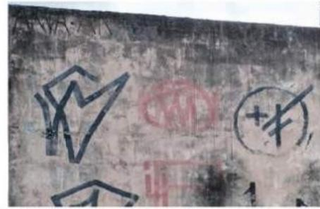
9b) Detalhe retirado da fachada norte, mostra Sujidade e Crosta Negra (D2) em grande parte da fachada.
