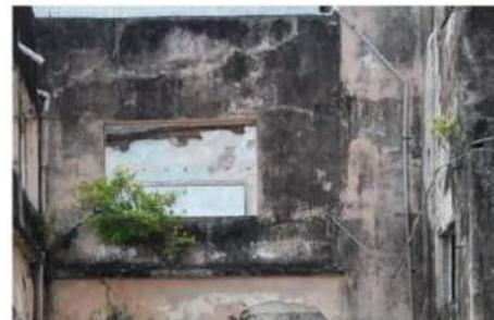
9d) Detalhe retirado da fachada norte, mostra a presença de vegetação (D11).
