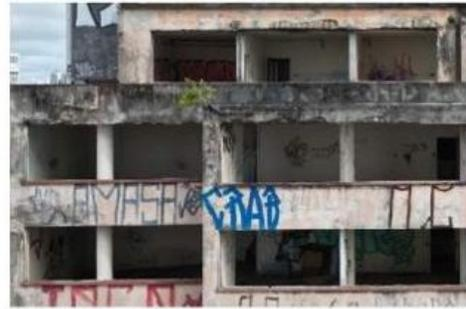
**8b** Detalhe retirado da fachada sul, mostra a presença de corrosão da armadura (D3) em grande parte do edifício.
