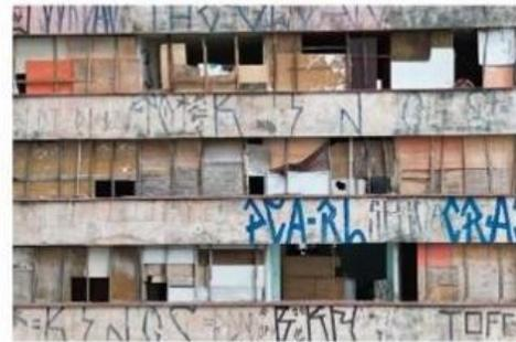
**8d** Detalhe retirado da fachada sul, mostra a instalação de tapumes (D10) em grande quantidade no edifício.
