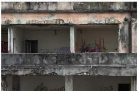
**8c** Detalhe retirado da fachada sul, mostra a retirada das esquadrias (D9) em grande quantidade por todo o edifício.
