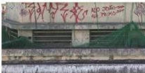
7a Detalhe retirado da fachado Oeste, mostra presença de Eflorescência pela fachada do edifício.
