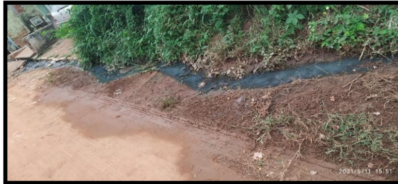
Figura 5 - Esgoto a céu aberto
