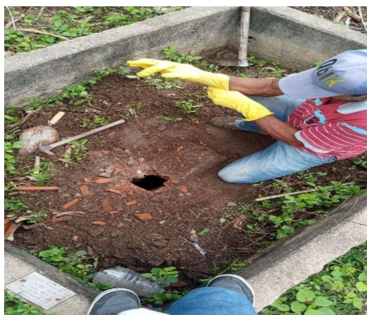
Figura 04 - Abertura da fossa verde do A25M
