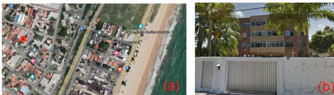
Figura 2: Localização Edifício Antilhas (a); Fachada Edifício Antilhas (b)
