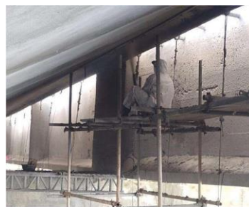
Figura 9b: Aplicação de concreto fluido
