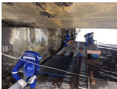
Figura 9a: Apicoamento dos pilares
