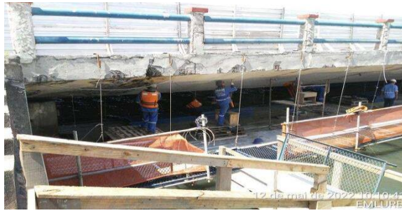
Figura 5a: Apicoamento da laje
