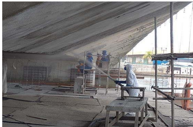
Figura 6: Revestimento de concreto projetado
